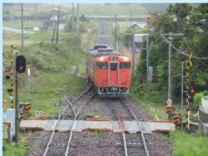
単線区間の行き違い設備
