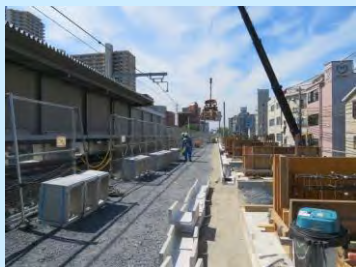
駅舎の解体、新設
