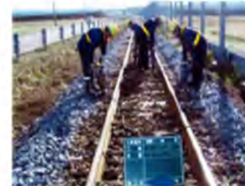
レールの修繕
