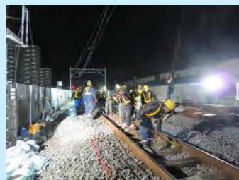
線路の配線変更
